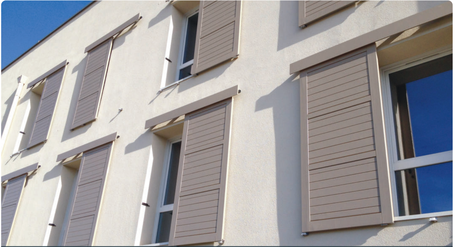
Volets coulissants à cadre en bois, 1 vantail frises horizontales – Finition peinture en option. Coloris : gris platine RAL 7036.
