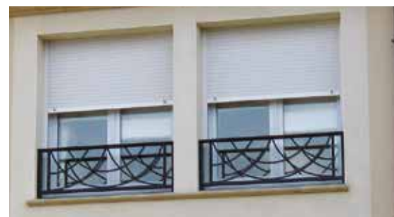
Main courante 50 x 25 mm arrêtes arrondies
