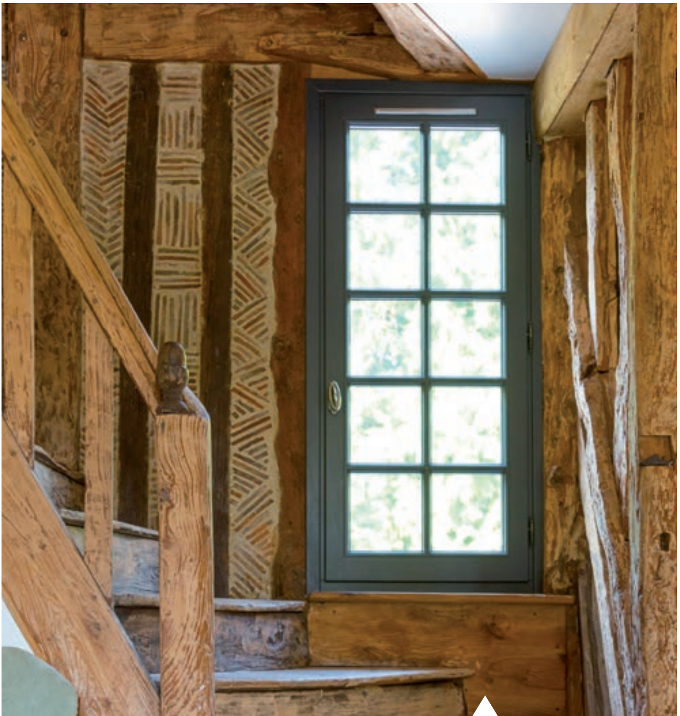
Fenêtre Estibelle un vantail Petits bois collés formant 10 carreaux égaux Finition peinture RAL 7024 Poignée olive et fiches turlupets vieil argent
