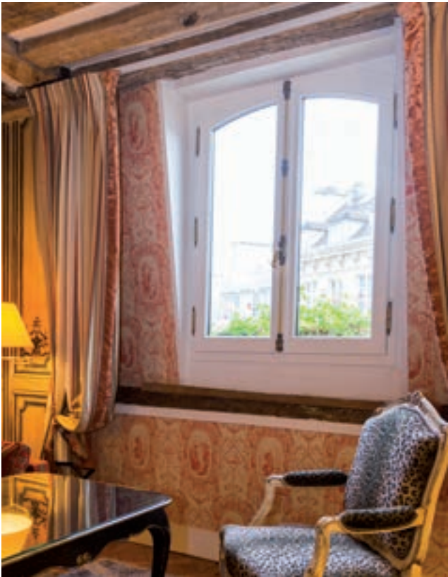
Fenêtre Estibelle avec dormant droit et vantaux cintrés
