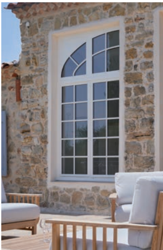
Imposte avec dormant coin mouchoir
