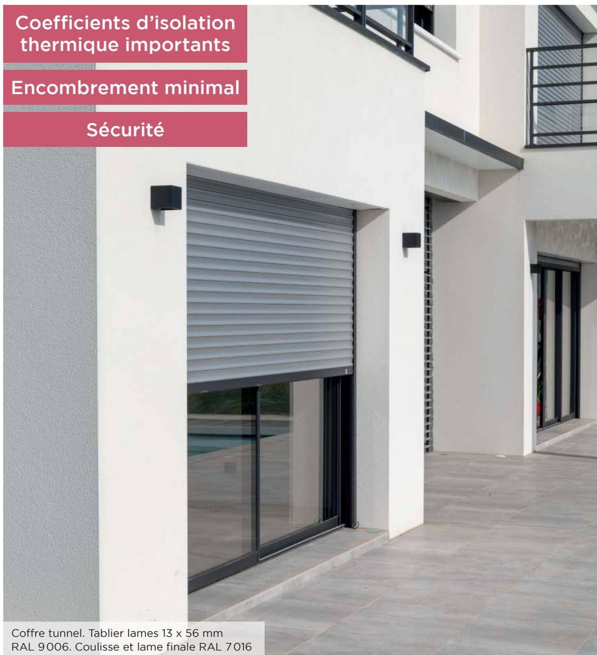
Coffre tunnel. Tablier lames 13 x 56 mm RAL 9006. Coulisse et lame finale RAL 7016
