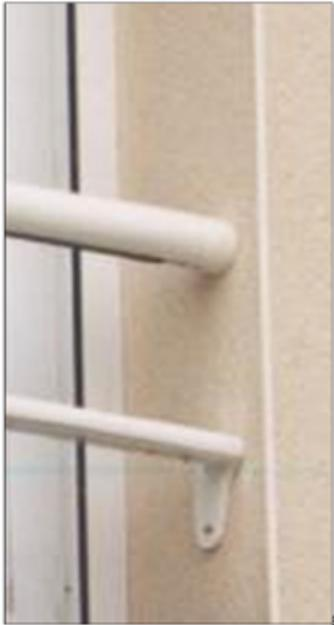
**Structure :** Profil aluminium de main courante Ø45 mm et de lisses 23x35 mm vissées dans le mur.
