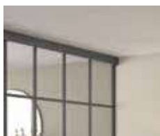
— pose au plafond
