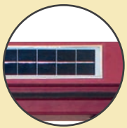
Capteur solaire intégré
