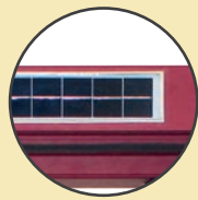
Capteur solaire intégré
