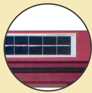
Capteur solaire intégré
